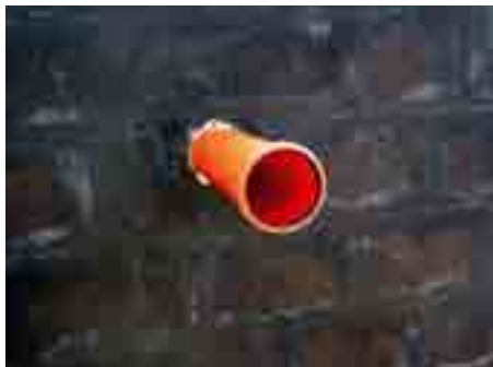
1. Cső csőtokkal, fal bitumenmázzal kellőstíve
