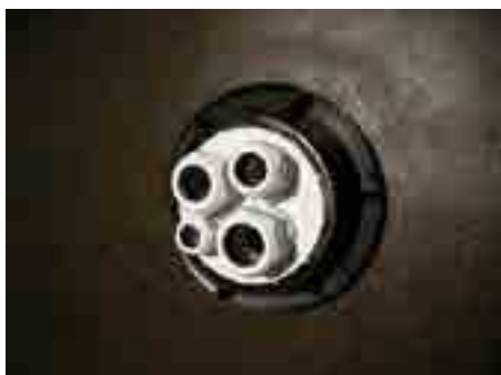
4. HL801 betételemet a rászertelt tömszelencékkel együtt az előkészített HL800/160 szigetelő elembe toljuk, majd a szorítóanyát rácsavarjuk és meghúzzuk.
